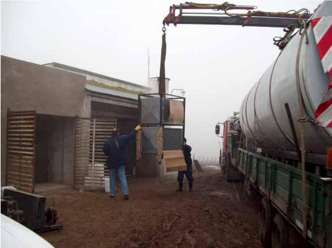
Instalación de un tanque con sistema de enfriamiento de leche en un tambo de Tandil.
